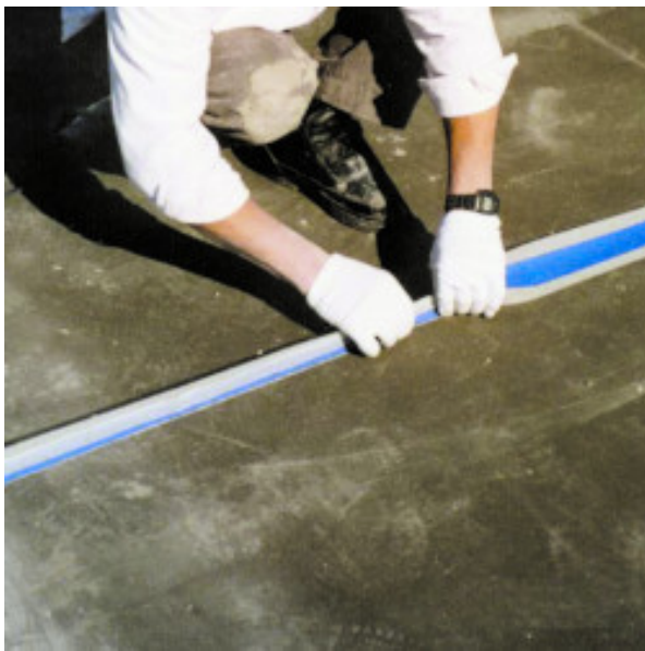
Abdichtung einer Dehnungsfuge auf einer Terrasse
