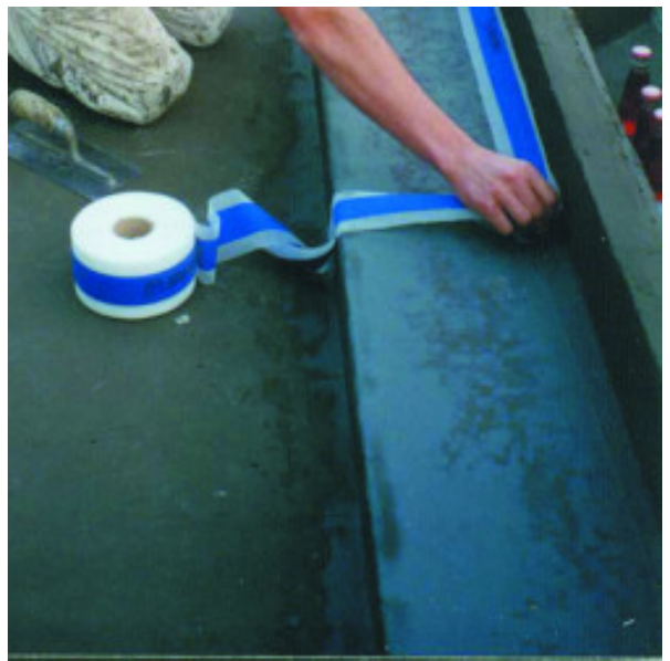
Einarbeiten von Mapeband im Boden-Wandanschluss eines Beckens
